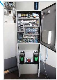
Armoire de puissance gérée par automate avec variateurs de vitesse
