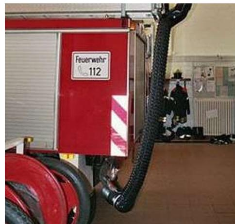
Der SLS ist die optimale Lösung bei der Abgasabsaugung, denn er passt sowohl für die neuen in der Heckschürze integrierten Auspuffanlagen als auch für die bisherigen extrem unterschiedlichen Auspuffendrohre. Mit dem patentierten SLS System kann zudem das Fahrzeug mit laufendem Motor auf der Hebebühne auf- und ab bewegt werden. Es sind keine zusätzlichen Adapter für die unterschiedlichen Auspuffenden mehr erforderlich. Der Schlauch kann nicht mehr überfahren und damit beschädigt werden.
